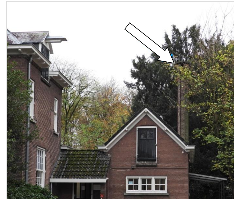
Het schoorsteentorentje (FH)
